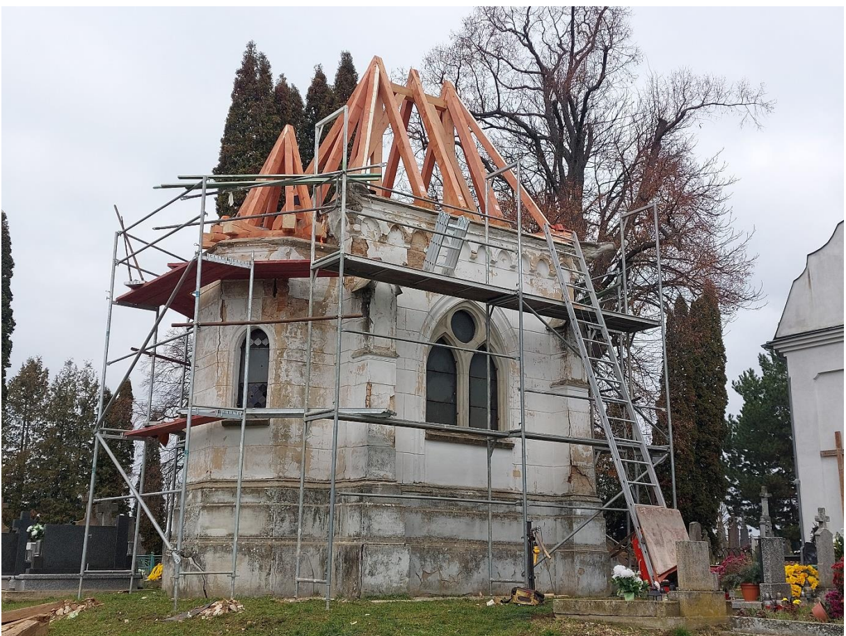
Ošetrovanie primárnych kovových kotiev a stav po montáži krovovej konštrukcie
