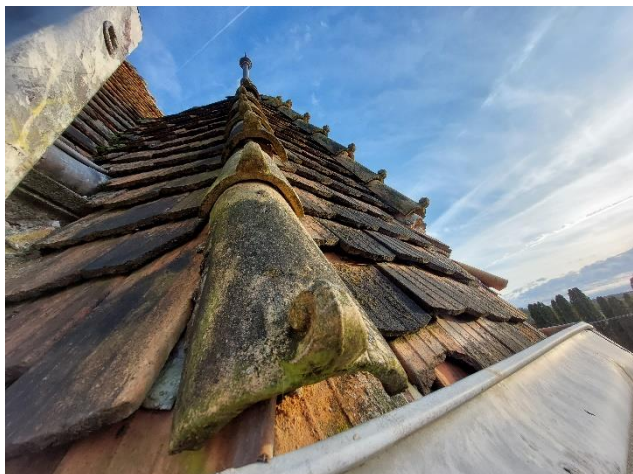
Stav strechy pred obnovou (detail)
