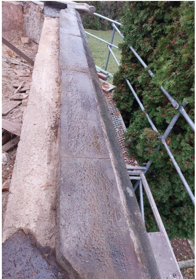
Konsolidácia kamennej časti pomúrnice.
