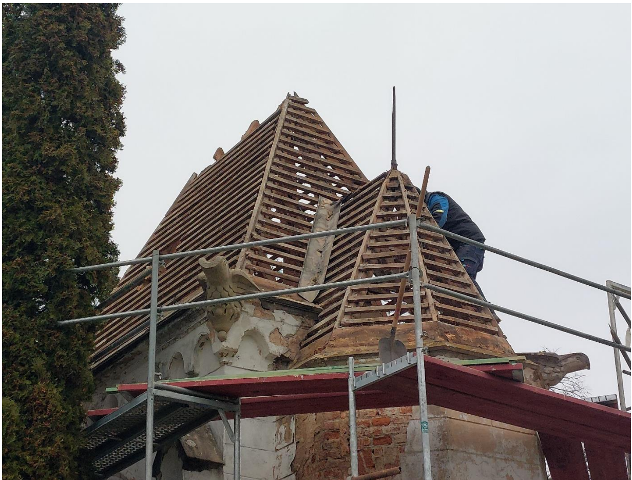
Demontáž opláštenia strechy
