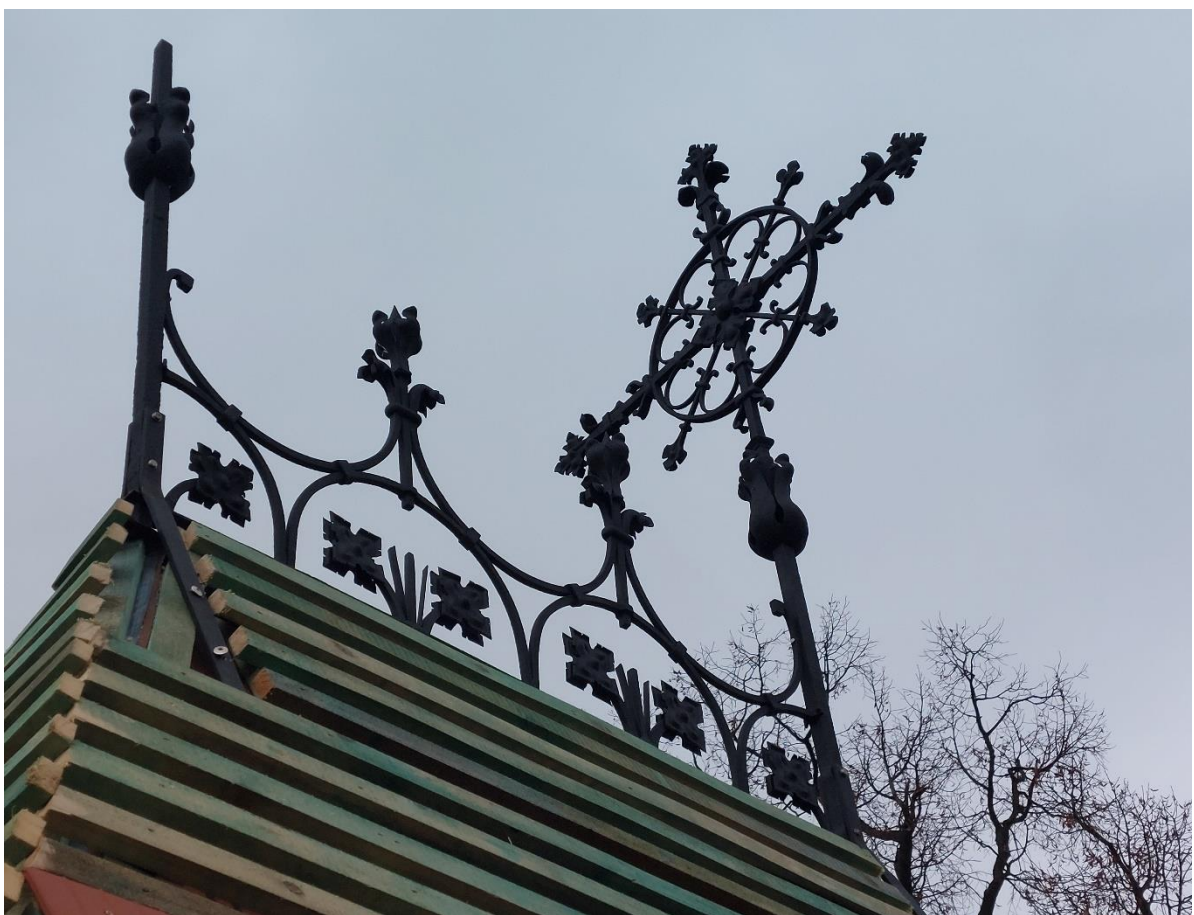
Inštalácia poistnej izolácie, latovania a montáž výzdoby štítu strechy
