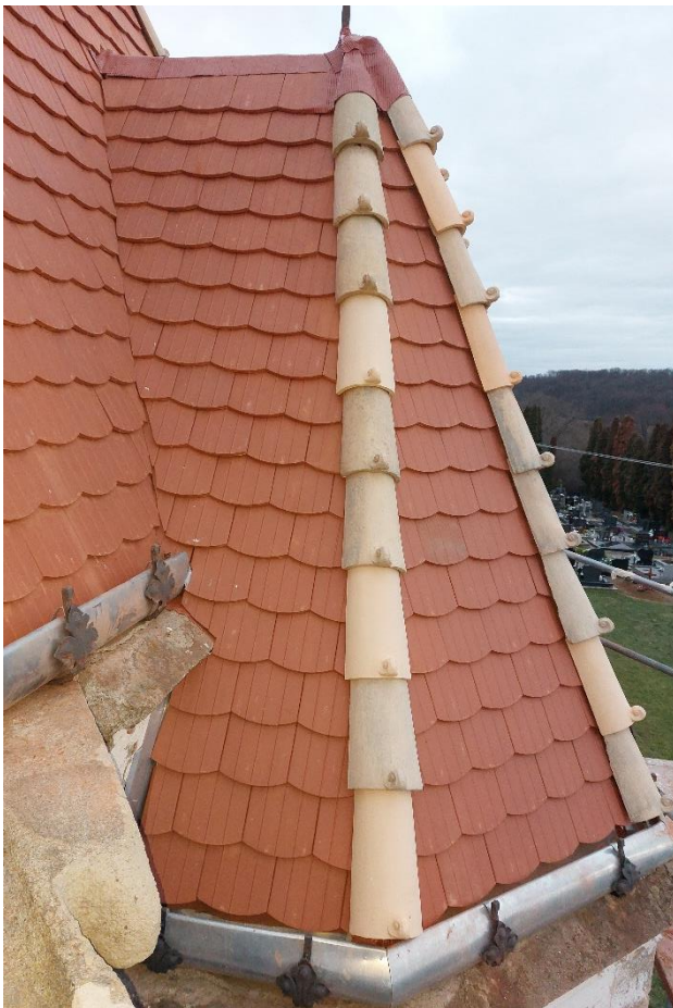
Inštalácia hrebenáčov a izolácie štítov strechy
