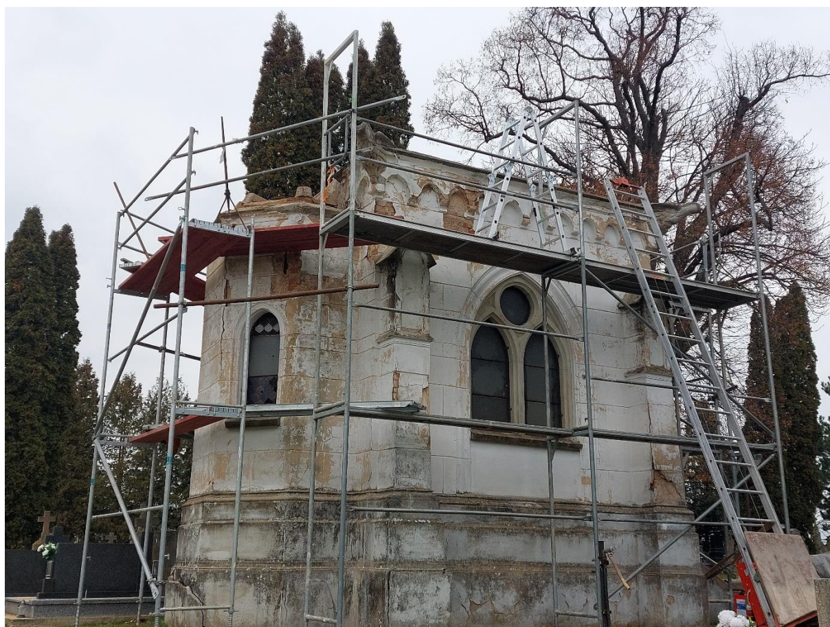
Stav po demontáži strechy pohrebnej krypty rodu Botkových
