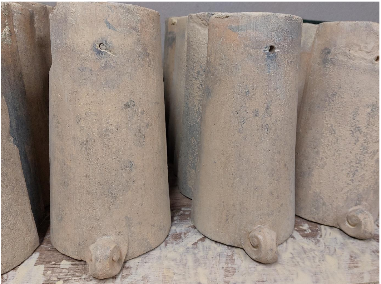
Stav hrebenáčov pred a po obnove
