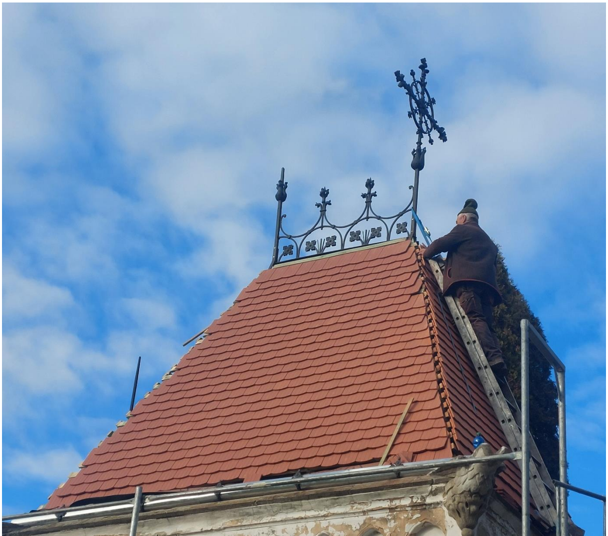
Fixovanie nového opláštenia strechy a dorezávanie nároží
